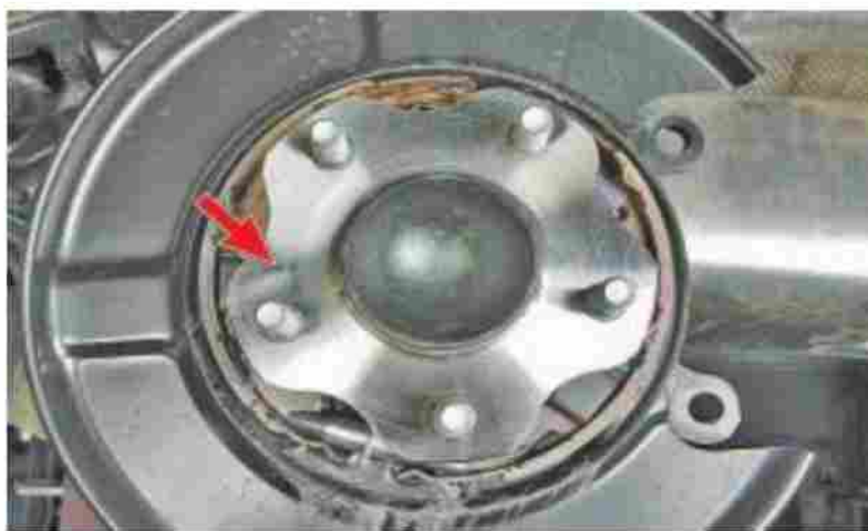
Рисунок–11 - Зачистка привалочных поверхностей
