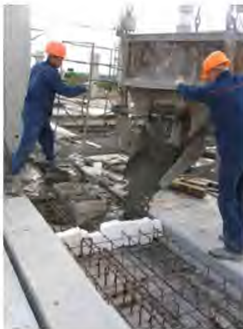
Фото 2. Устройство монолитного участка
