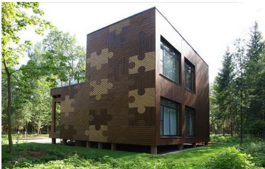
Рисунок 34. Облицовка деревянными панелями
