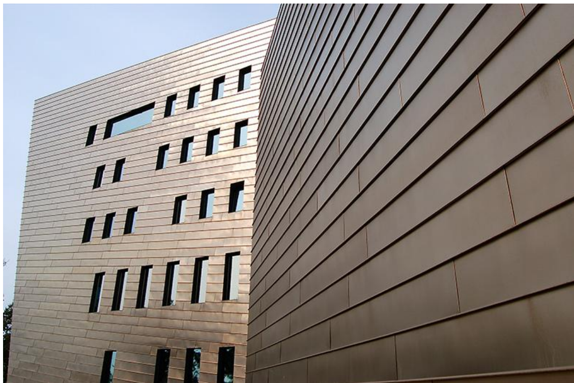
Рисунок 9. Пример внешней облицовки металлическим фасадным сайдингом
