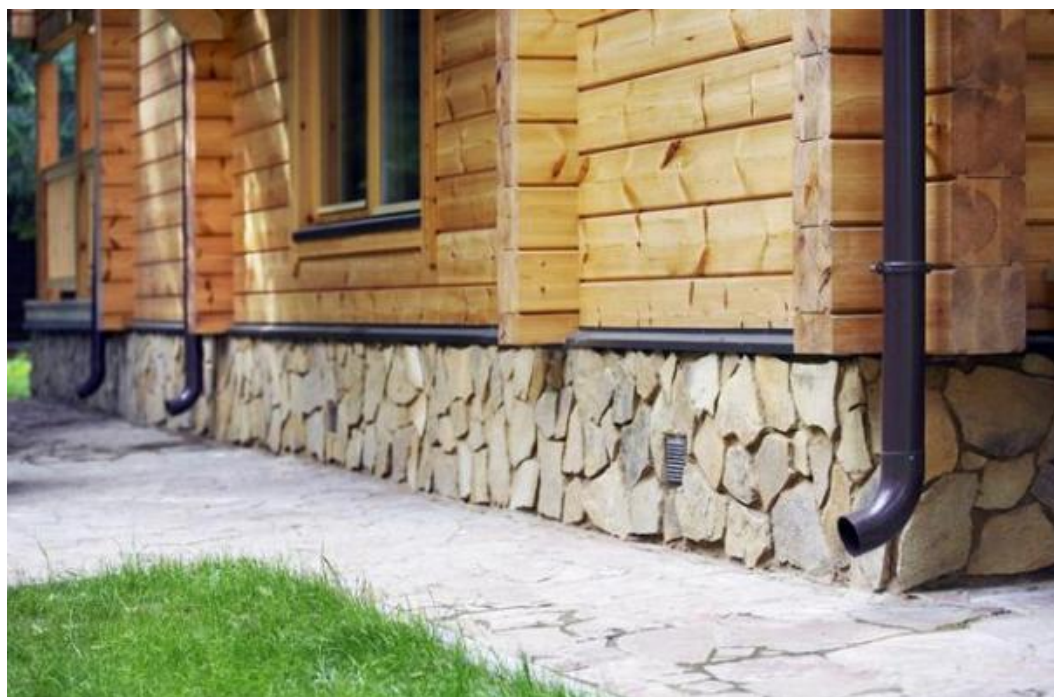
Рисунок 10. Пример внешней облицовки цоколя натуральным камнем
