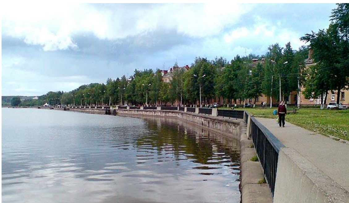
Рис. 1. Ул. Мира, г. Воткинск, Удмуртская Республика.
