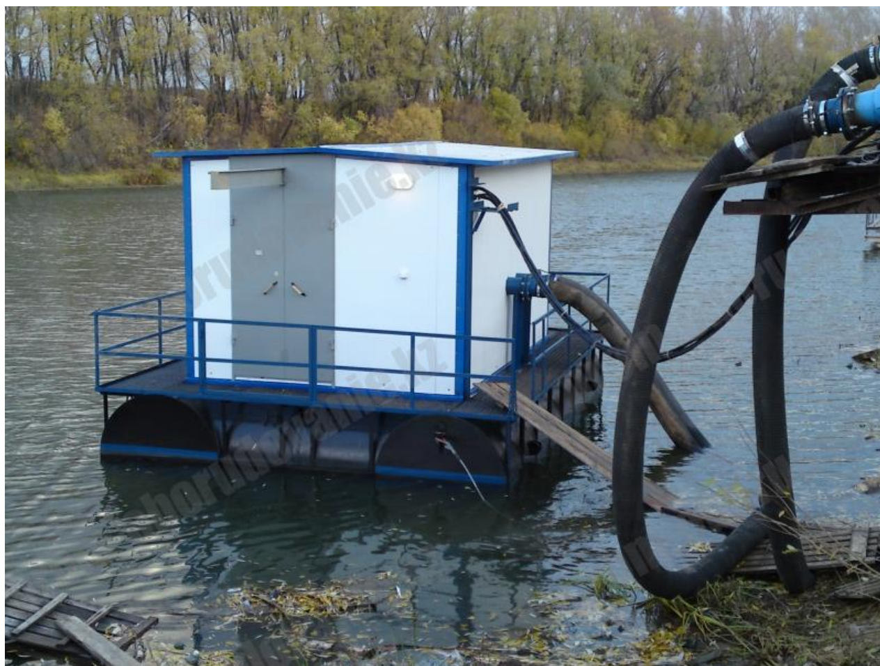
Рисунок 3.2 – Плавающая насосная станция
