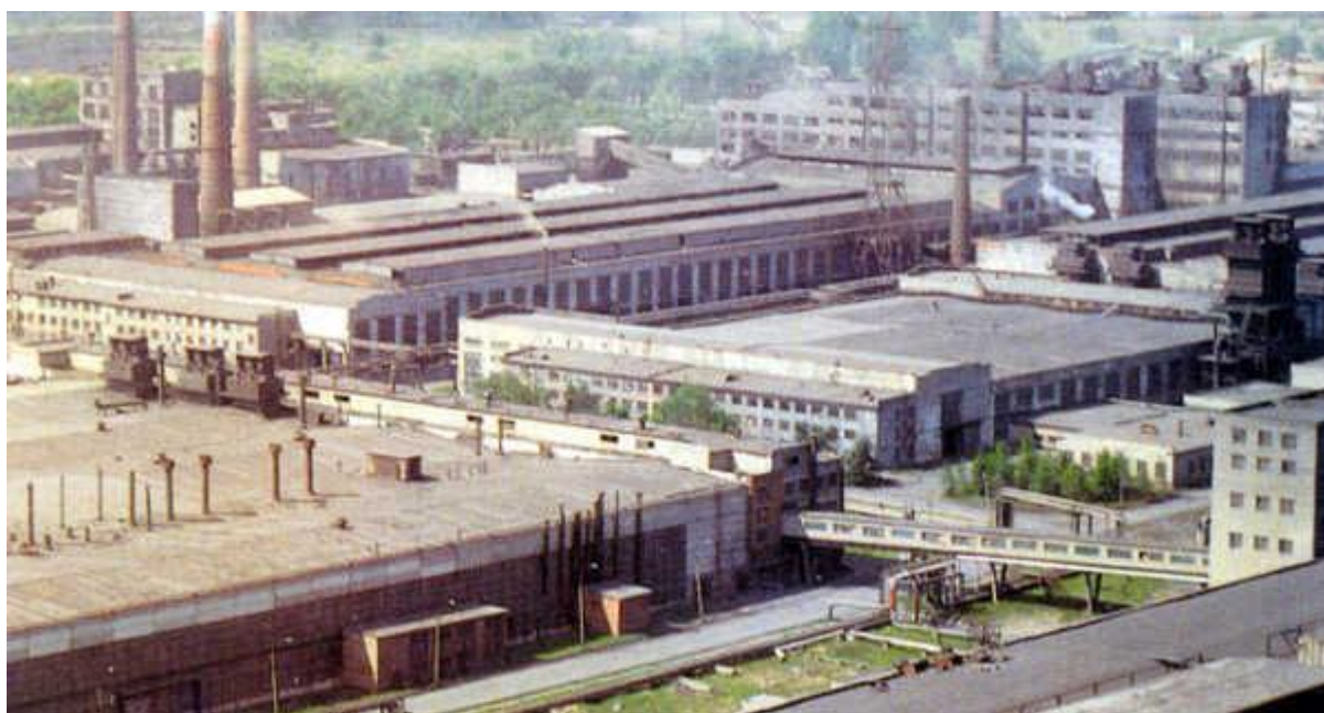
Рисунок 1.1 – Территория ОАО «Энергопром – ЧЭЗ».
