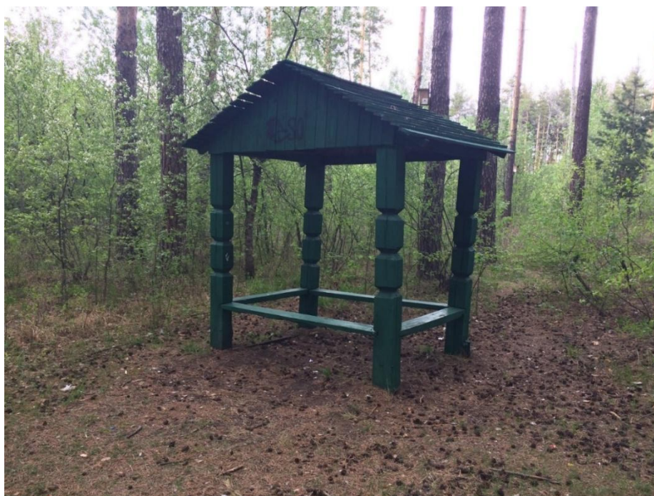
Рисунок 2.12 – Беседка в исправном состоянии
