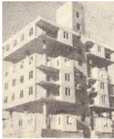
Рисунок 1.6 – Процесс возведения здания методом подъема этажей.
