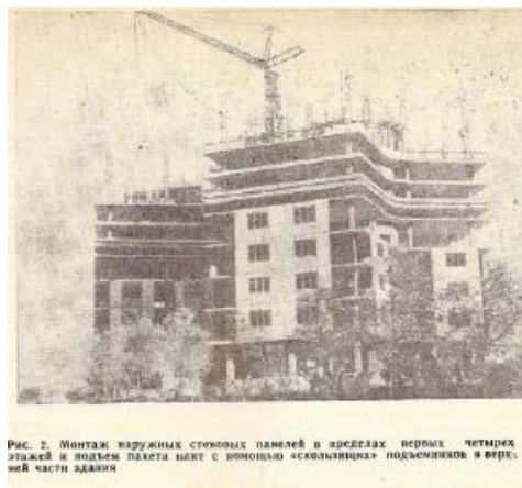
Рисунок 1.7 – Процесс возведения здания методом методом подъема перекрытий.
