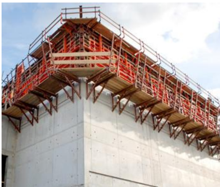
Рисунок 1.2. – Строительство здания с помощью скользящей опалубки.
