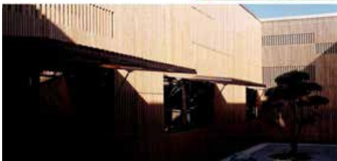
Внутренний двор производственного здания деревянного дома в Эрххайме, Германия
