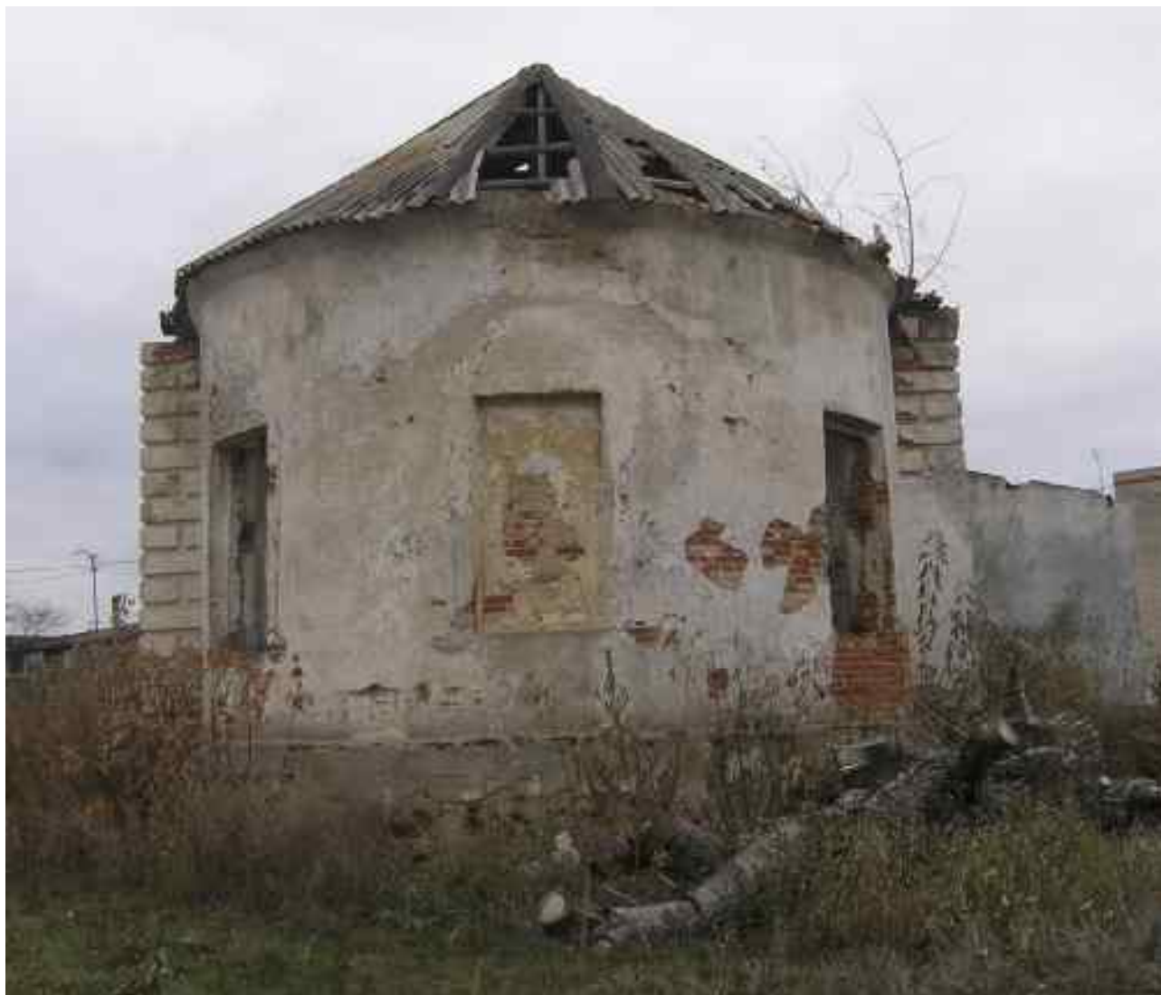
Рис. 1.2. Восточный фасад церкви (фото 2016 года)
