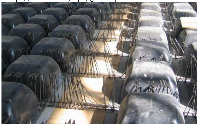
Рисунок 3.1.12 Установка каркасов первой очереди
