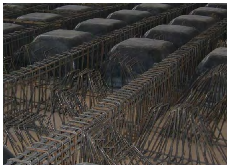
Рисунок 3.1.12 Установка каркасов второй
