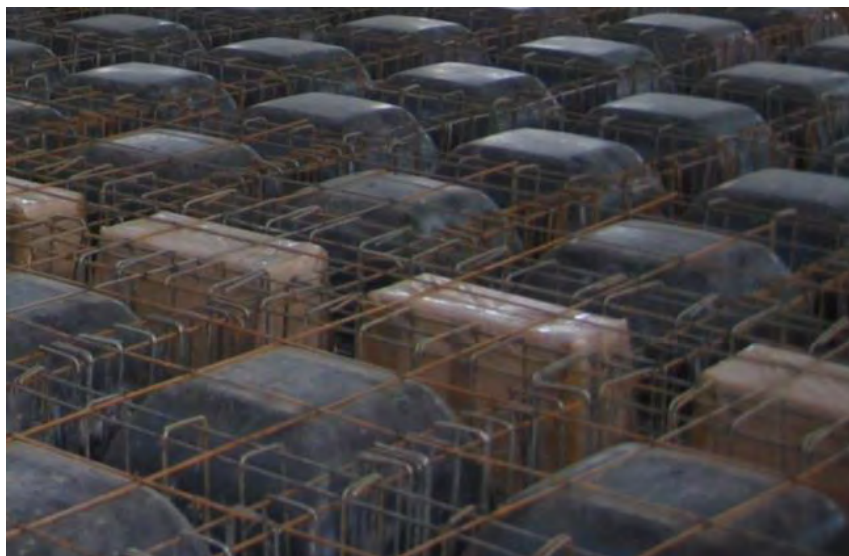
Рисунок 3.1.12 Установка верхней арматуры каркасов первой очереди.
