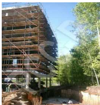
Рис.10. Подвесные строительные леса
