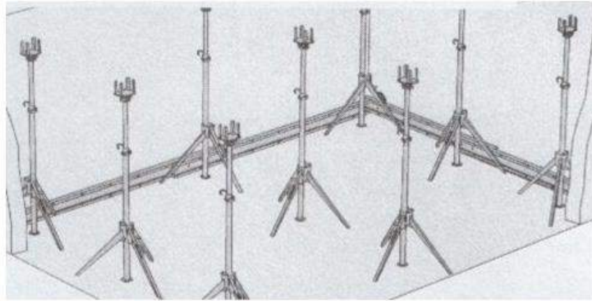
Рисунок 11 – Общий вид помещения после монтажа основных стоек
