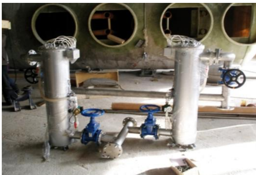
Рисунок 1.9 – Узел УФО во время сборки [14]
