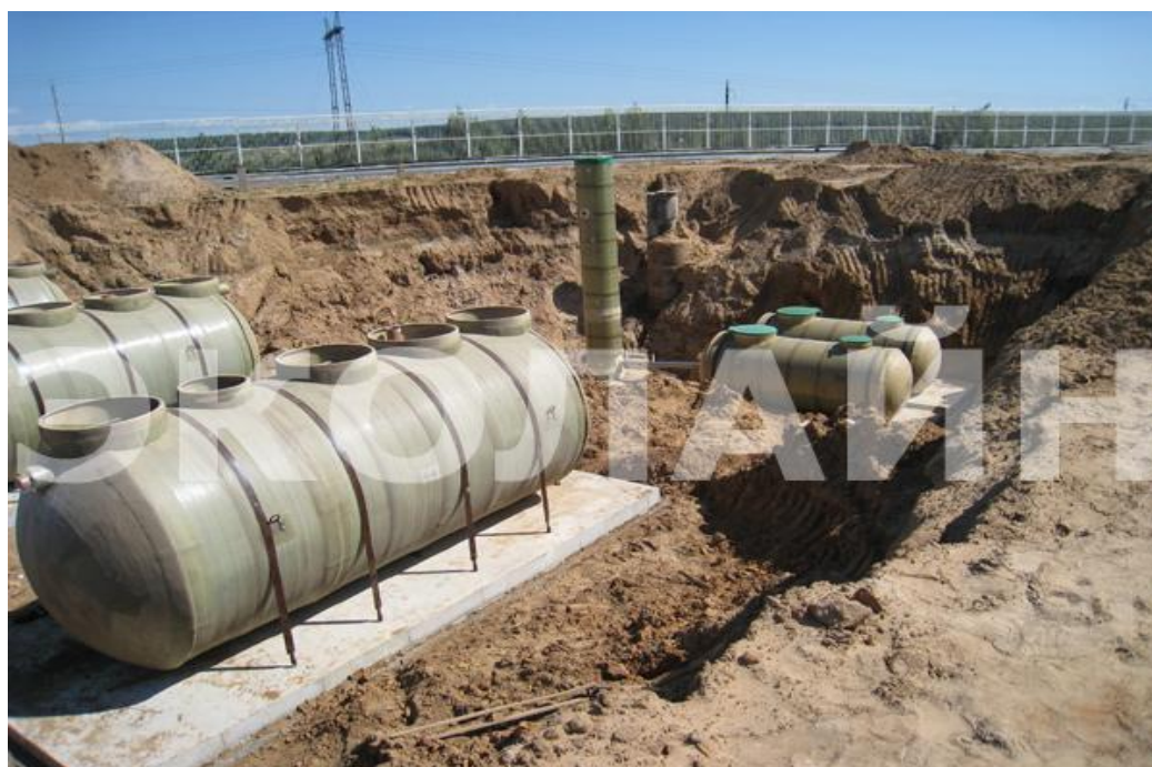
Рисунок 1.11 – Монтаж КОС ЭКО-Р-240 [15]
