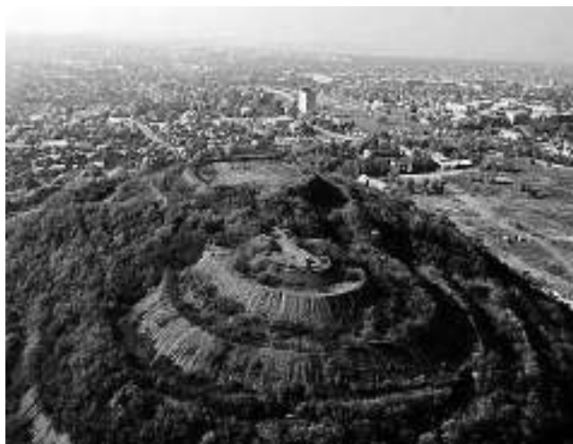
Рисунок 10,11. Пример террасирования терриконов Донбасса.
