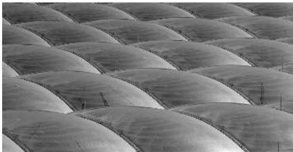
Рис. 35 Подушки из полимера ETFE.
