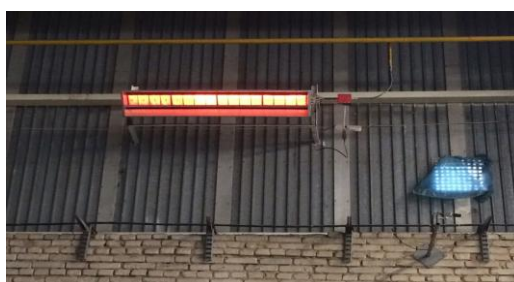
Рисунок 22 – Инфракрасное отопление
