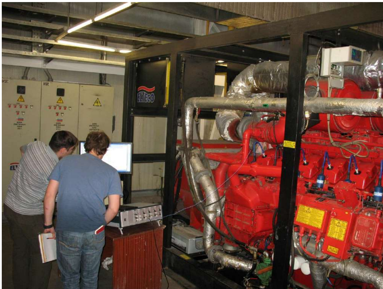
Рисунок 22 – Настройка аппаратуры измерения давления «Нейва 10000»
