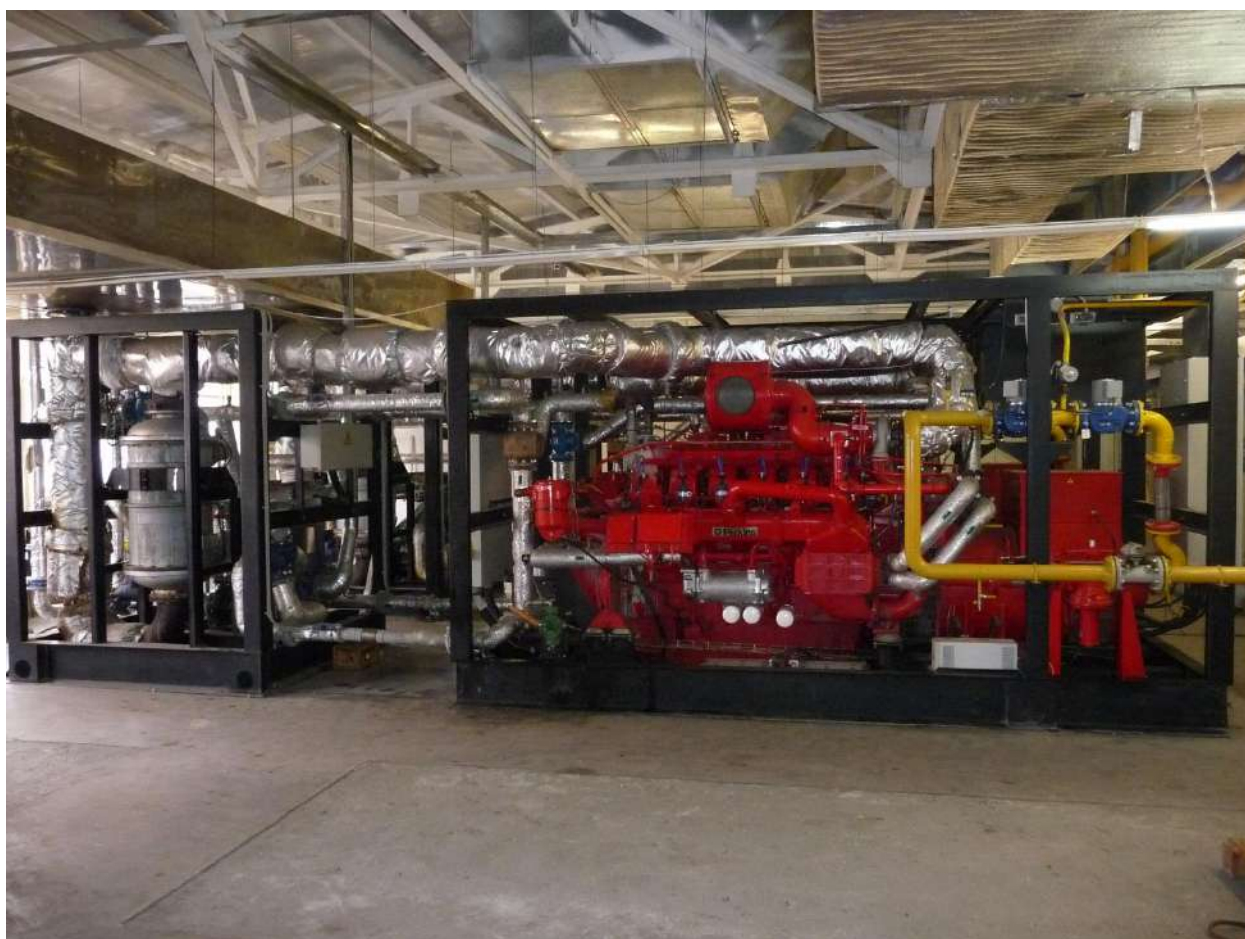
Рисунок 11 – Когенераторная установка Elteco Petra 750 CGC, установленная в энергоцентре Южно-Уральского государственного университета
