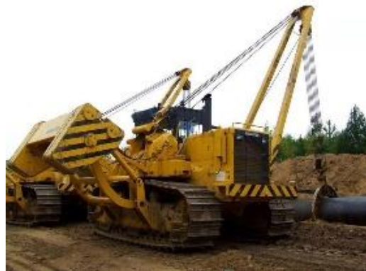
Рисунок 1.7 – Кран-трубоукладчик Komatsu D85C-21
