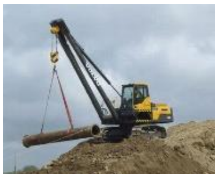
Рисунок 1.9 – Кран-трубоукладчик Volvo PL3005D
