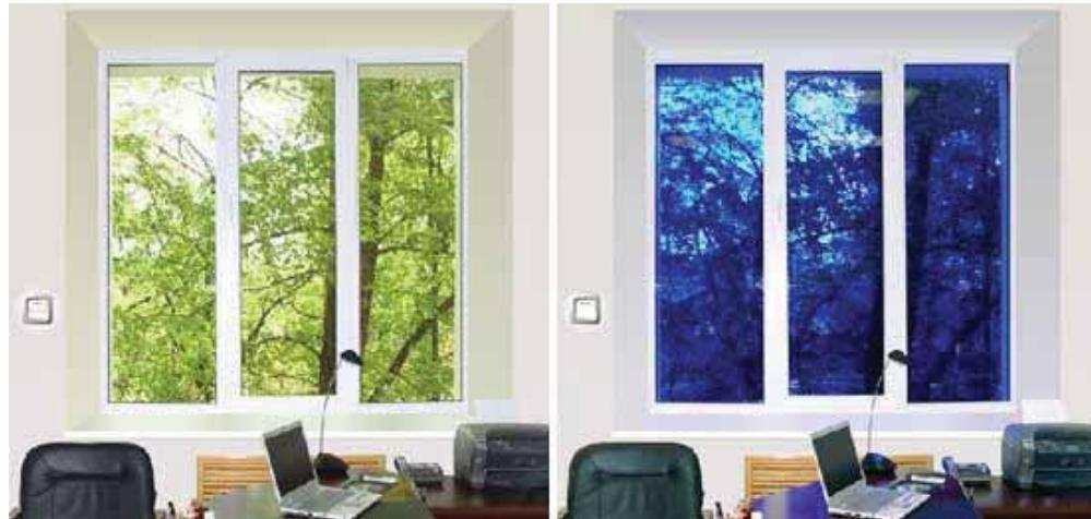
Рисунок 1.9 – Электрохромное смарт-стекло: а – отключено, б – включено
