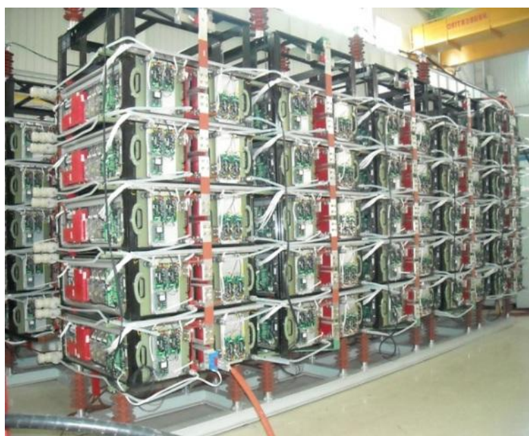
Рисунок Б.2 – Фото одной фазы преобразователя
