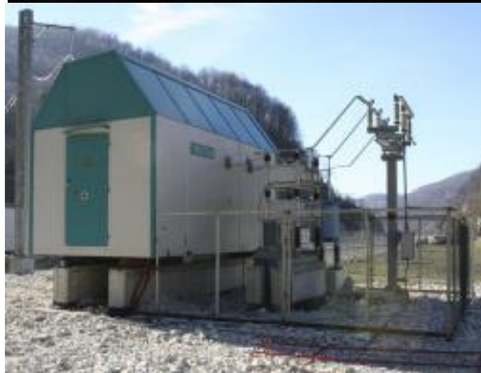
Рисунок Б.5 – Внешний вид установок продольной компенсации
