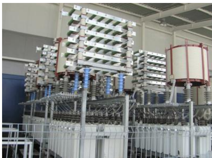
Рисунок Б.4 – СТАТКОМ на ПС 220 кВ Могоча в Забайкальском крае
