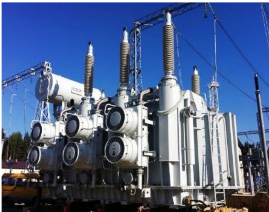
Рисунок 3.1 – Автотрансформатор
