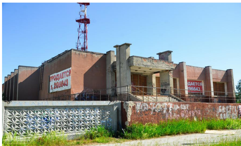
Рисунок 3.1 – Здание по адресу: ул. Индустриальная 61
