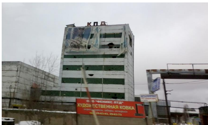
Рисунок 3.5 – Здание по адресу: ул.Северная
