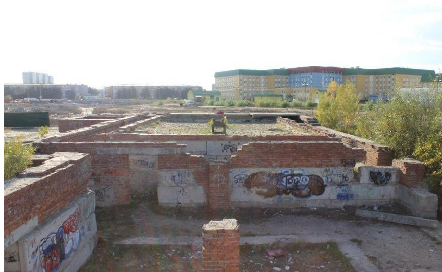
Рисунок 3.4 – Здание по адресу: территория Комсомольского озера
