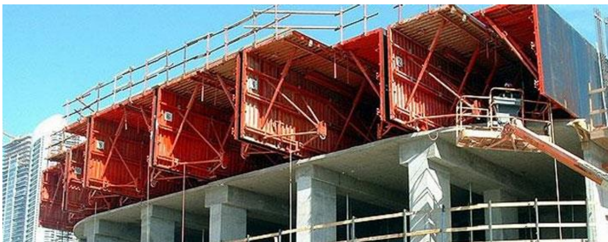
Рисунок 14 – Туннельная опалубка
