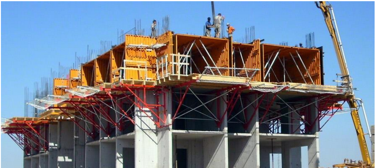
Рисунок 27 – Устройство туннельной опалубки
