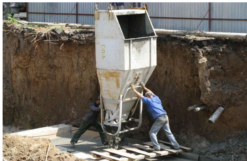
Рисунок 4 – Подача бетонной смеси: а – бетононасосом; б) – бадьей-«туфлей»
