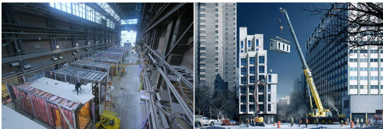
Рисунок 27 – Производственный этап; монтажная стадия
