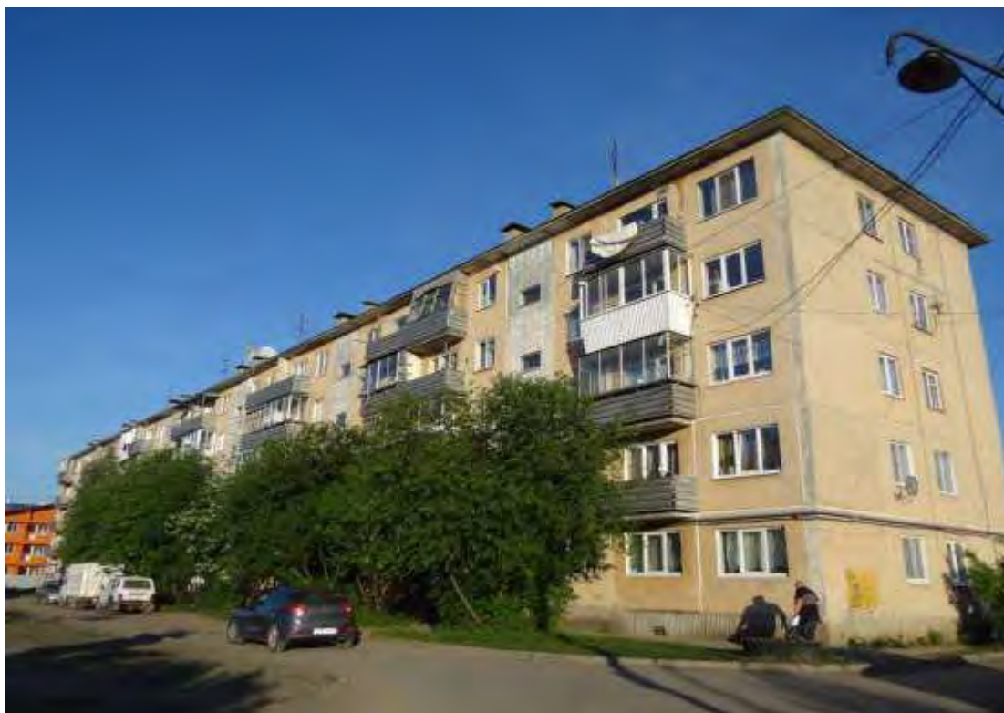
Рисунок 3.12 - Внешний вид здания
