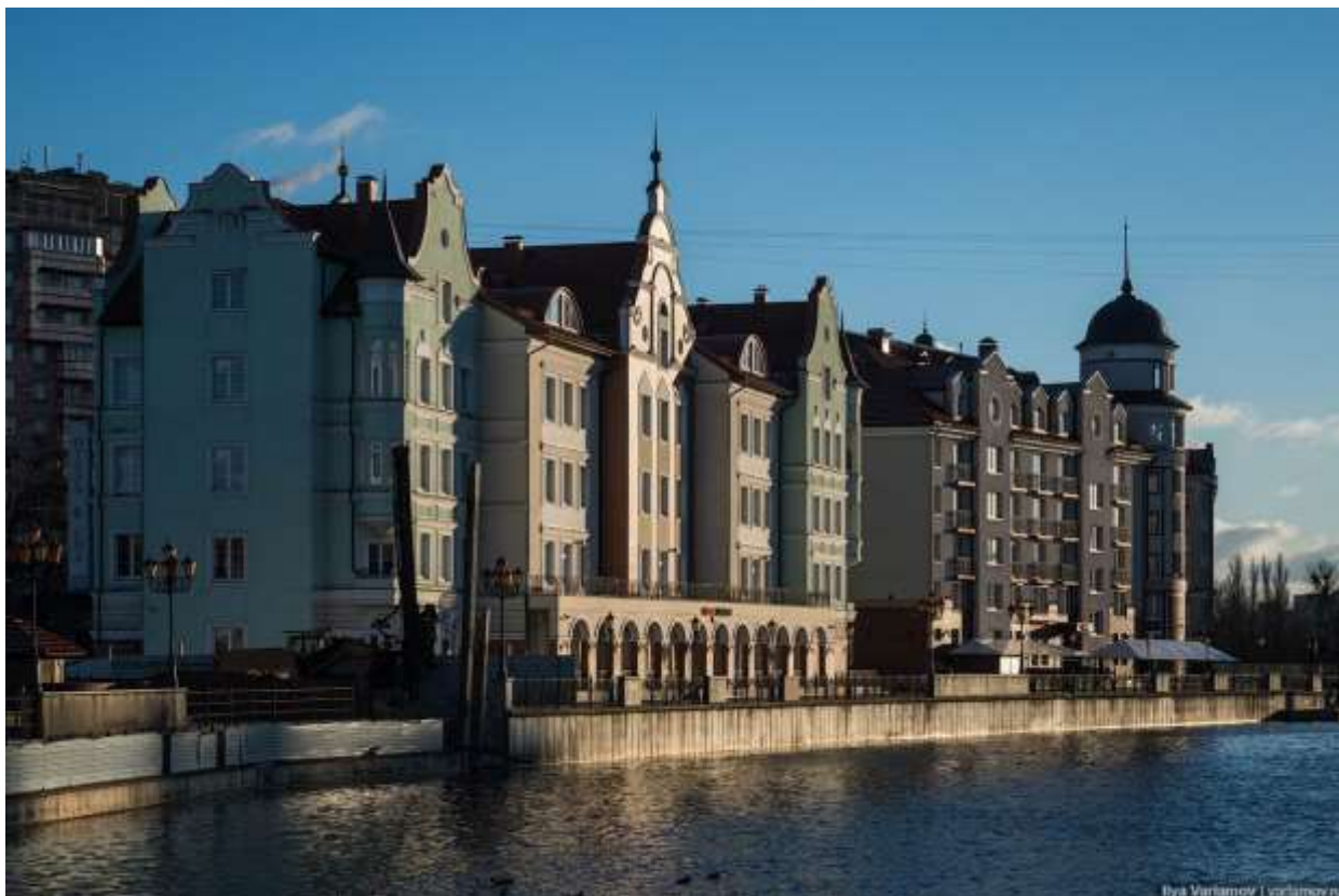
Рисунок 26– Реконструкция хрущевок, г. Калининград
