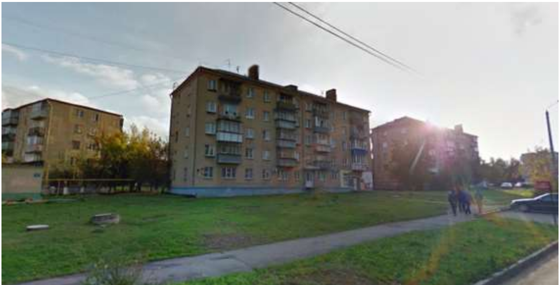
Рисунок 43 – Фасады зданий до реконструкции
