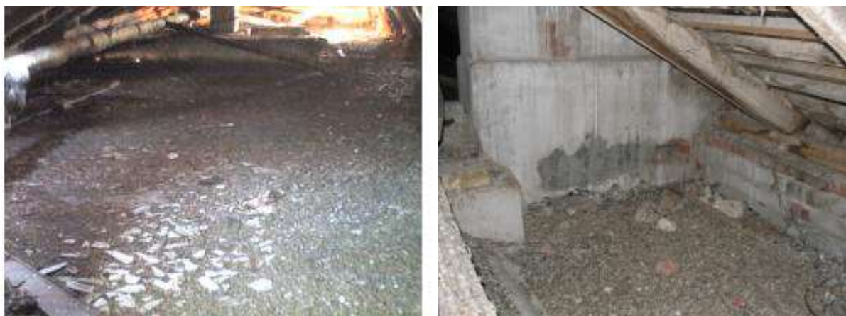
Рисунок 32 – Чердачное помещение жилого дома серии 1-447
