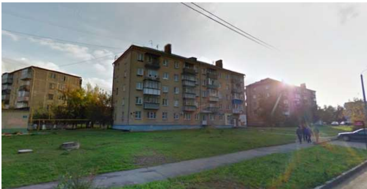
Рисунок 31 – Общий вид многоквартирного жилого дома.
