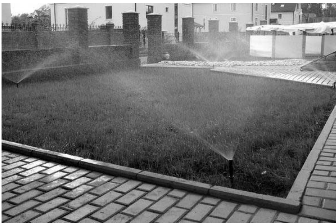
Рисунок 13 – Орошение газона дождевателями в системе автополива
