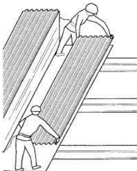
Рис14. Укладка стального профилированного настила на металлические балки.
