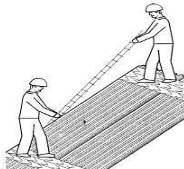
Рис16. Раскладка арматурных каркасов.
