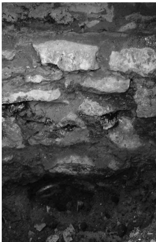
Рис.5 Вид бутового ленточного фундамента в шурфе, вскрытом при обследовании.
