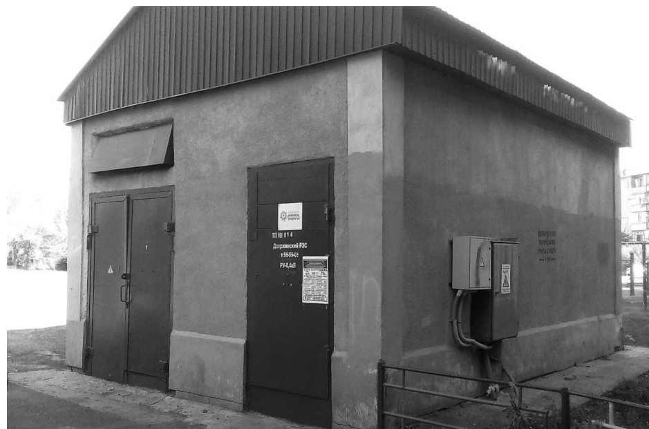
Рисунок 1.4 – Трансформаторная подстанция, преобразующая напряжение 10 кВ в 0,4 кВ
