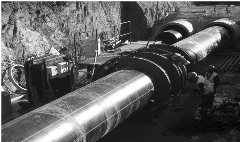
Рисунок 6 – Сварка полиэтиленовой трубы
