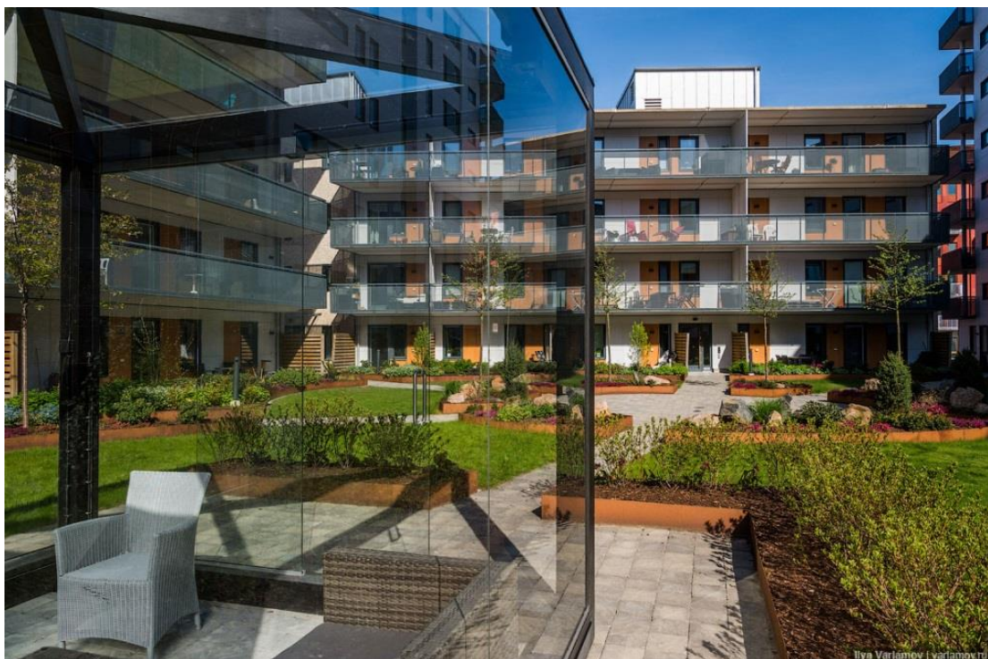
Рис. 2.15 Благоустройство и озеленение жилой застройки Гётеборга
