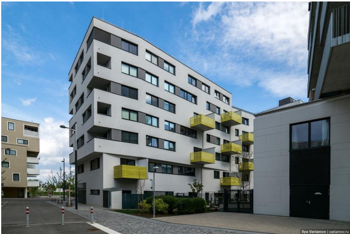
Рис. 2.12 Благоустройство среднеэтажной застройки в Вене
