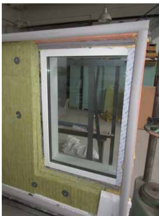
Рис.3.1.14. Изображение испытуемой модели (Расхождение граней в стыке между блоками, с разрушением связующего клеевого состава, прямоугольной формы, толщиной 10 мм, высота 140 мм, глубина 190 мм. Наличие в пенном шве пустот в количестве 2шт, габаритными размерами 80х30х140 мм.) утеплитель 100 мм. до помещения в камеру.
