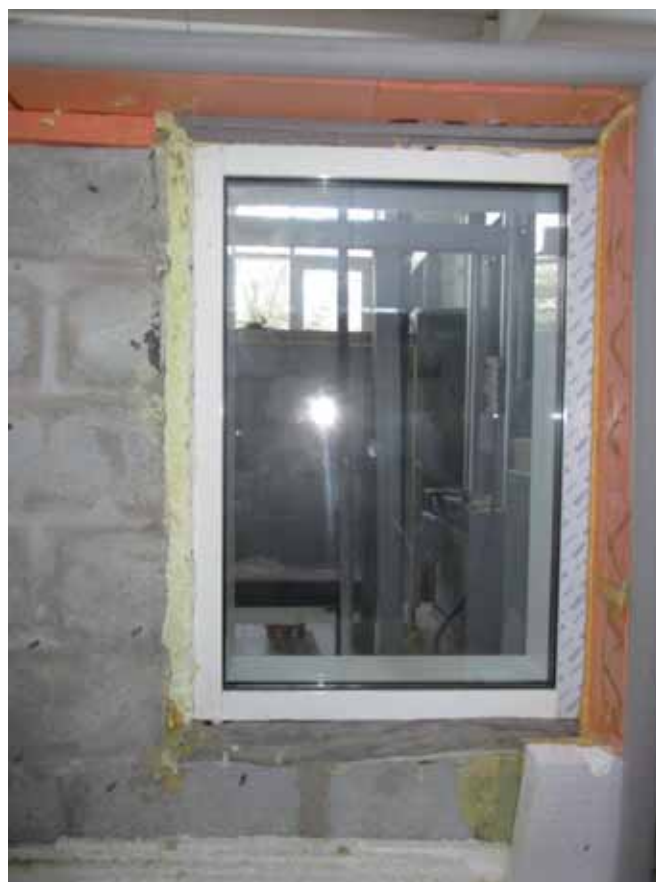
Рис.3.1.18. Изображение испытуемой модели (без дефектов) без утеплителя до помещения в камеру.
