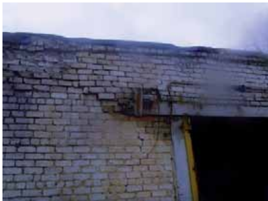
Рис.2.2.5. Выпучивание кирпичной кладки
