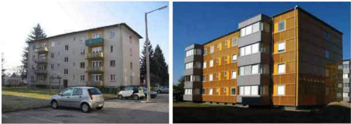
Рисунок 1.12 – Реконструкция жилого дома по адресу г. Грац, ул. Дизельвег. Слева до реконструкции, справа после реконструкции.
