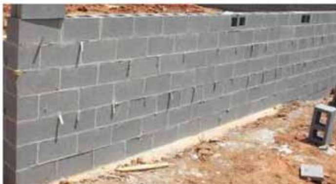
Рис. 18 – Стены из шлакоблока
