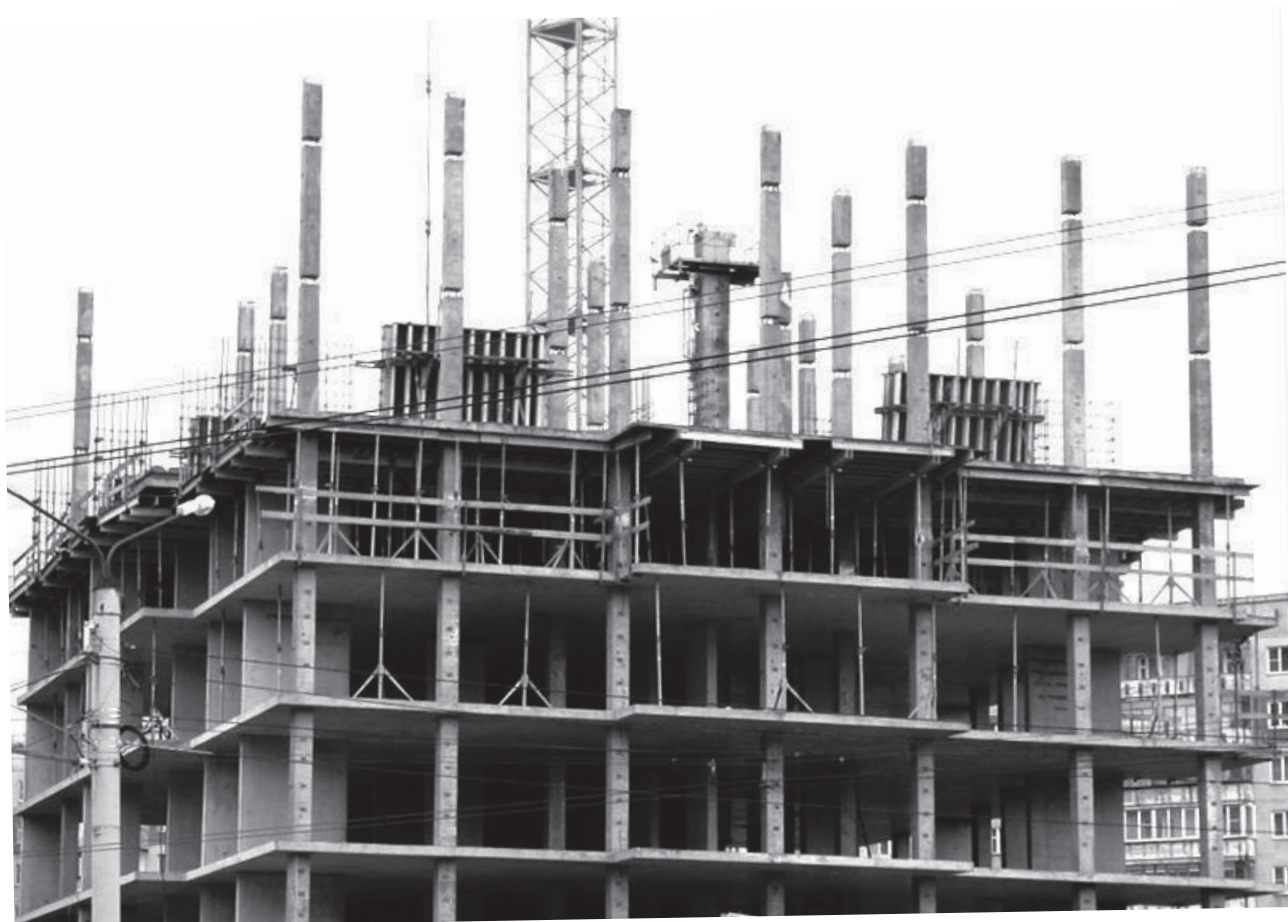
Рис. 6. Безбалочные монолитные перекрытия по сборным колоннам
