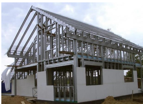
Рисунок 2.2. Сооружения с применением стального каркаса
