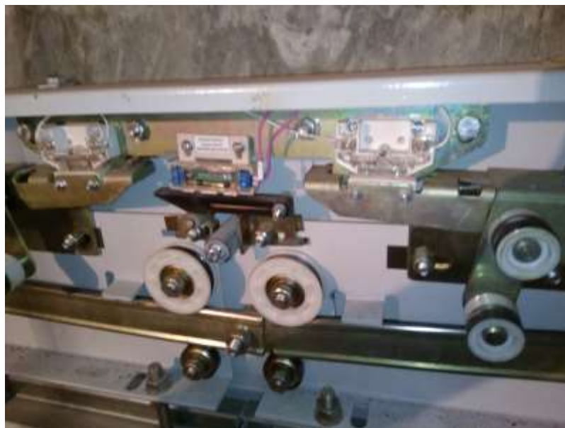
Рисунок 14 - Верхняя часть дверей шахты
