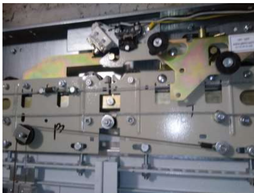
Рисунок 22 – Верхняя часть дверей шахты
