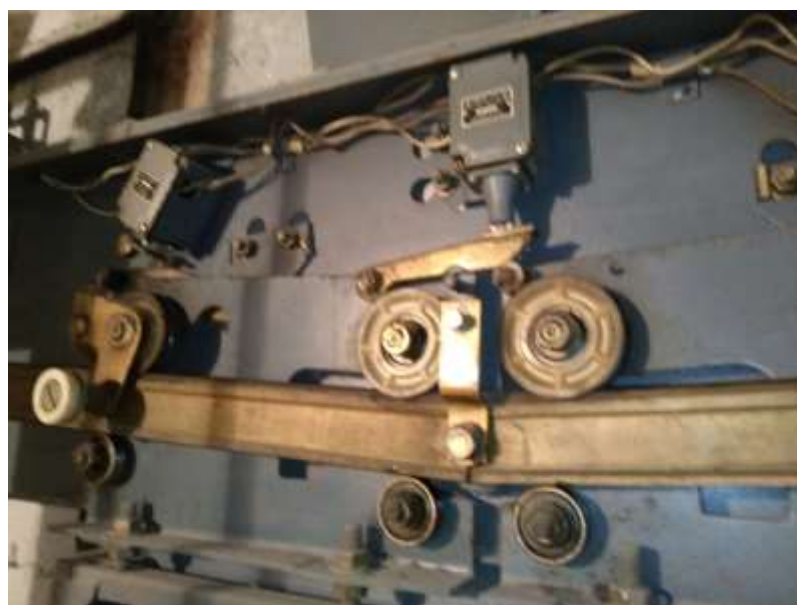
Рисунок 5 – Верхняя часть дверей шахты
