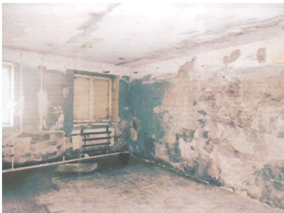
Рисунок Б.4 – Вид объекта оценки внутри
