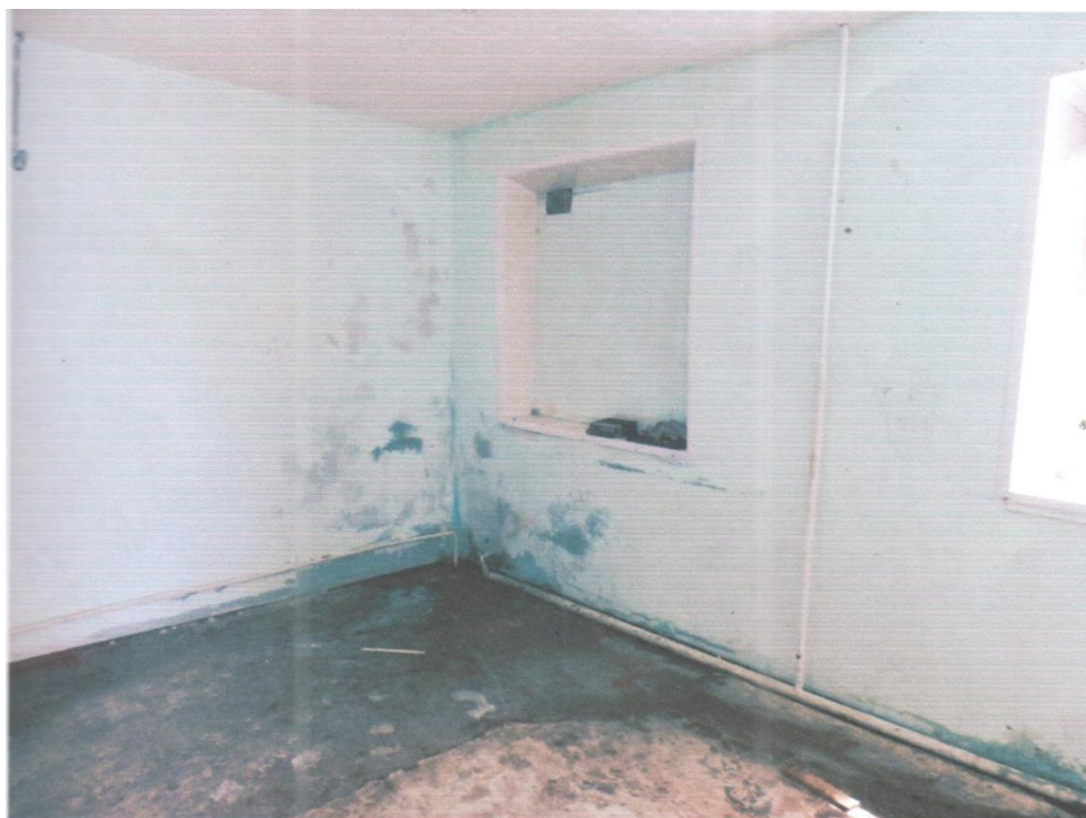
Рисунок Б.3 – Состоянии отделки объекта оценки
