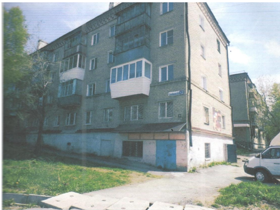
Рисунок Б.1 – Вид здания, в котором расположен объект оценки
