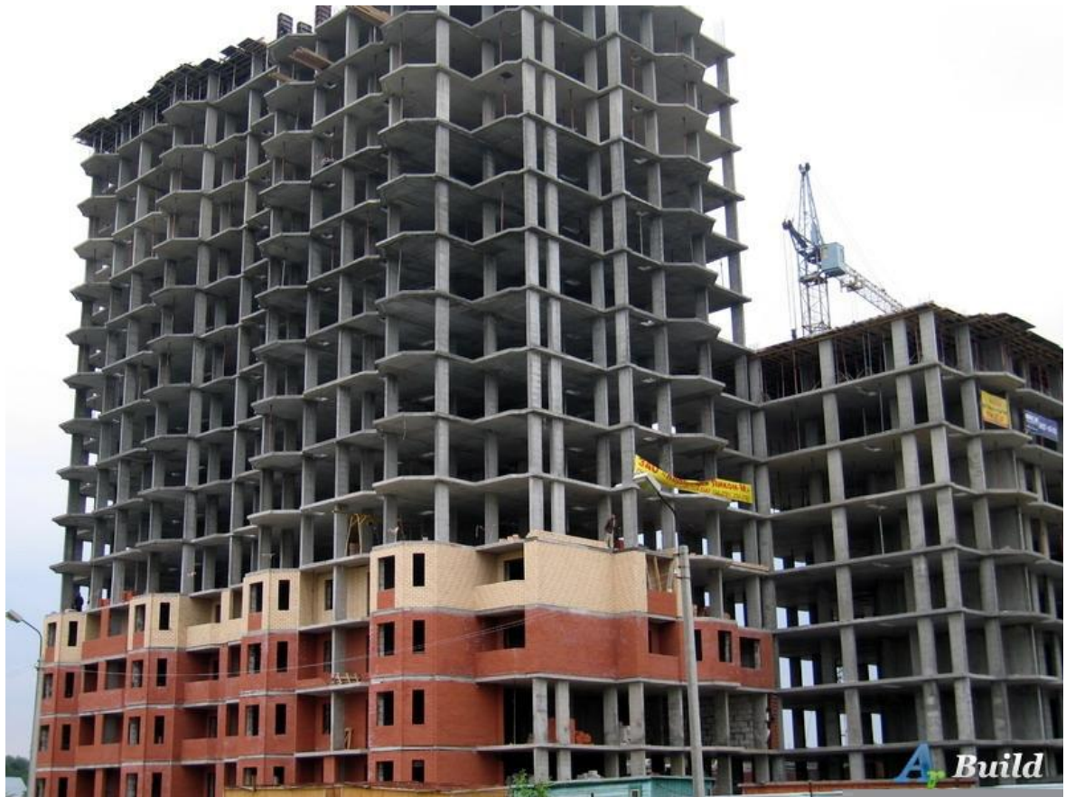
Рисунок 5.4 – Строительство каркасно-монолитного жилого дома
