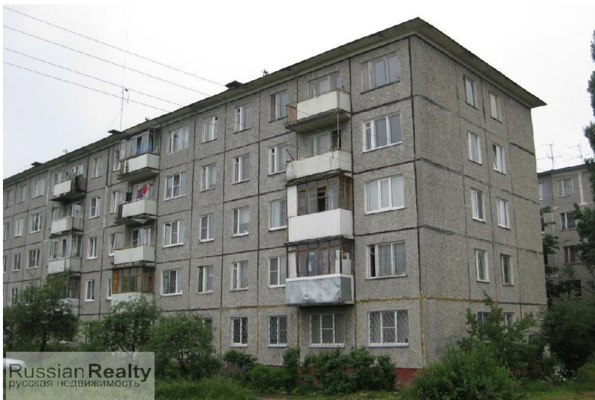
Рисунок 5.1 – Панельный пятиэтажный жилой дом
