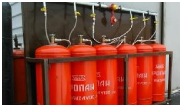
Рисунок 9 – Правильное хранение газовых баллонов
