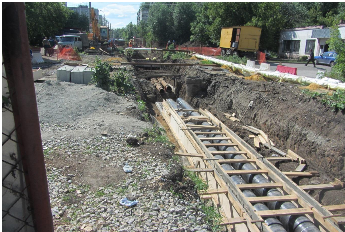
Рисунок 1.2 – Место проведения работ строительного-монтажного участка
