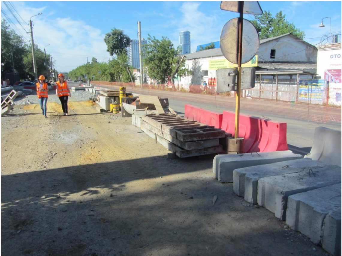
Рисунок 1.3 – Ограждение места проведения работ
