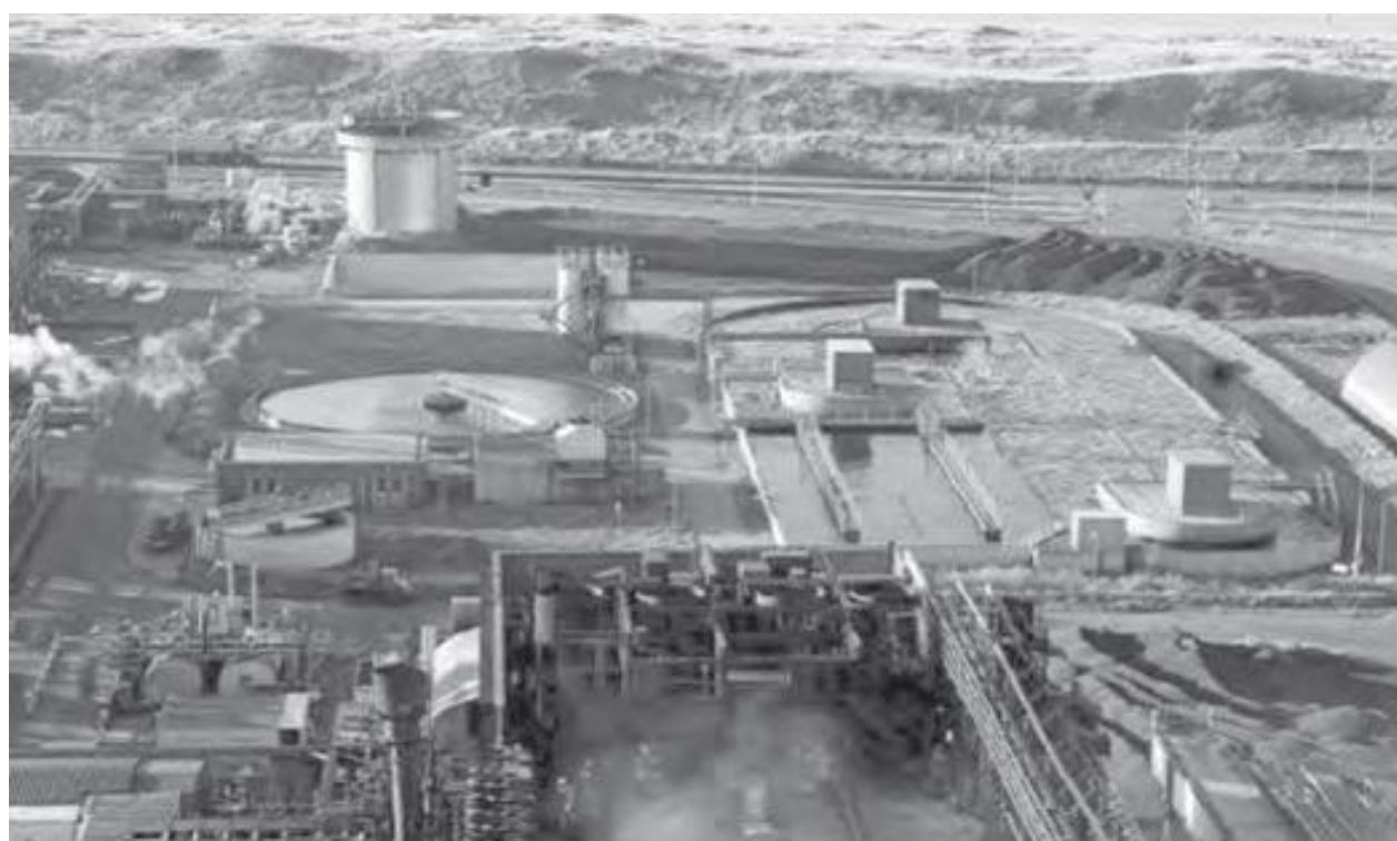
Рисунок 8 – Вид сверху установки для биологической очистки сточных вод компании Cogus, Эймейден, Нидерланды
