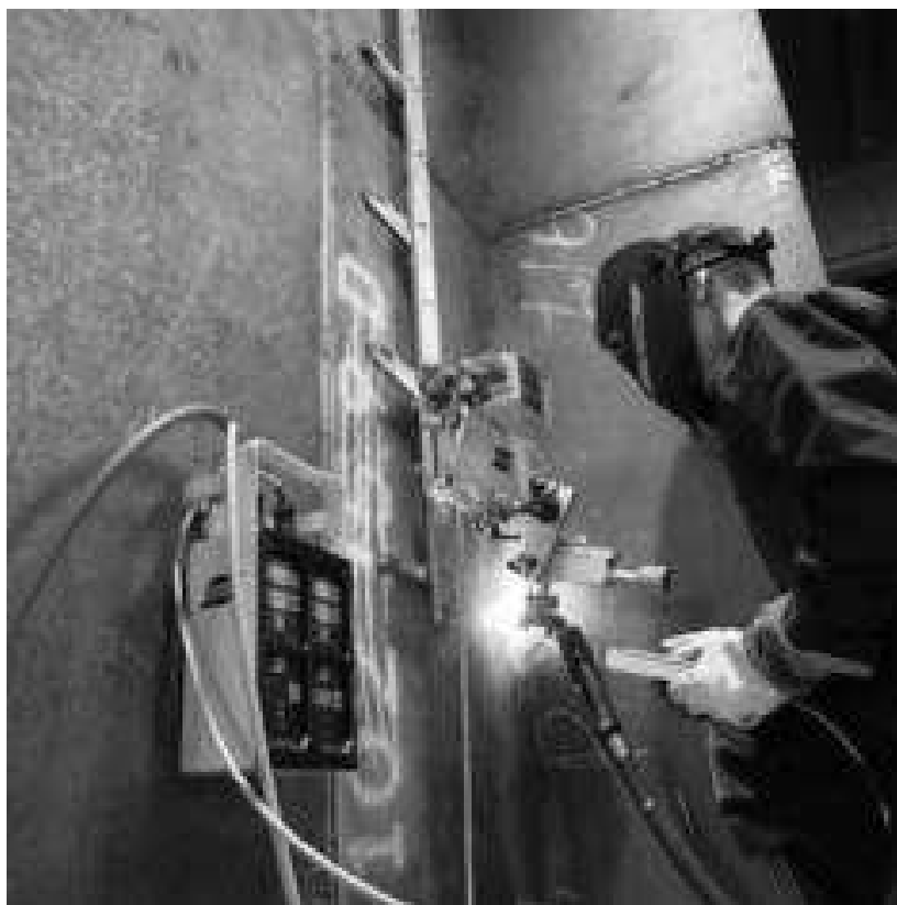
Рисунок 2.18 – Процесс работы ESAB Railtrack F 1000 на магнитных опорах
