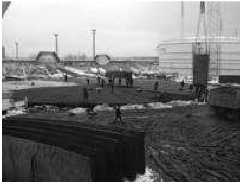
Рисунок 2.7 – Площадка установки резервуара
