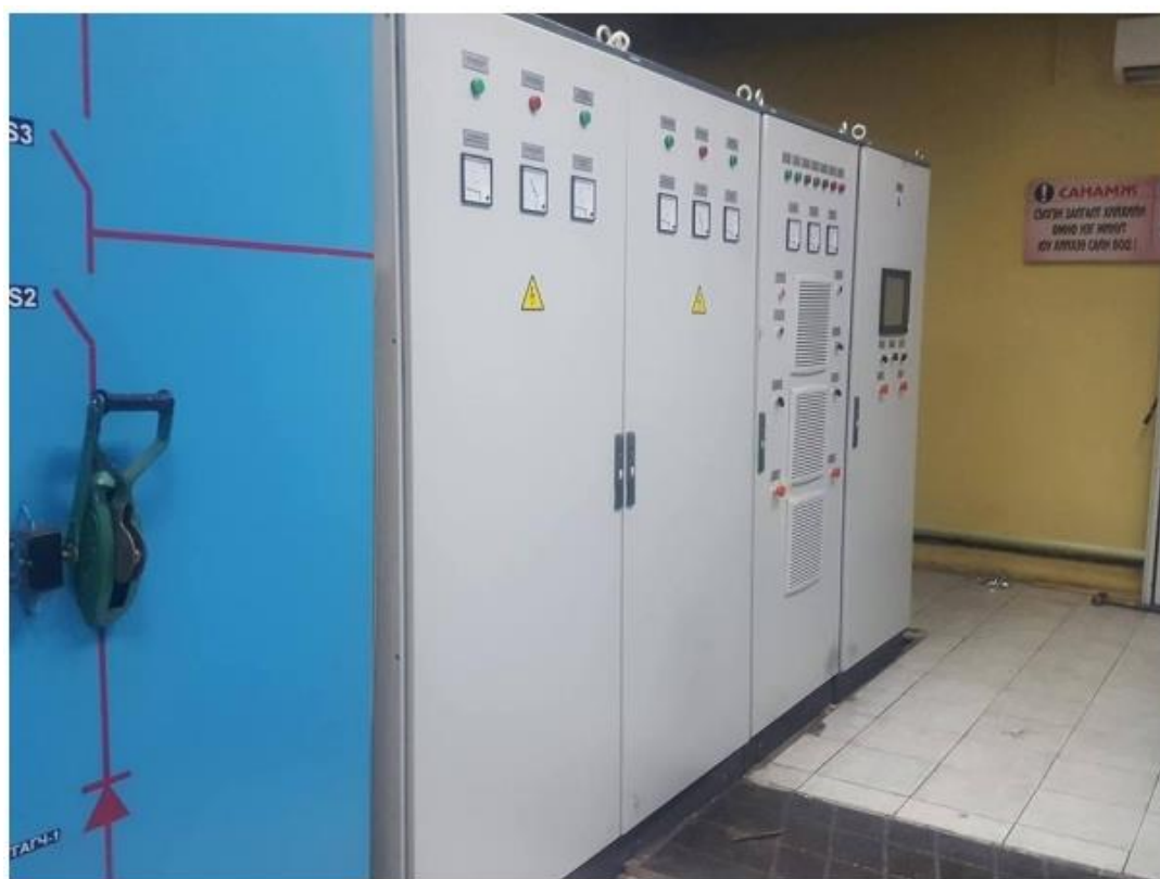
Рисунок 3.3 – Импульсный преобразователь тока Щит ПТИ-1250
