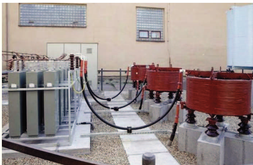
Рисунок 6.6 - Конденсаторные батареи
