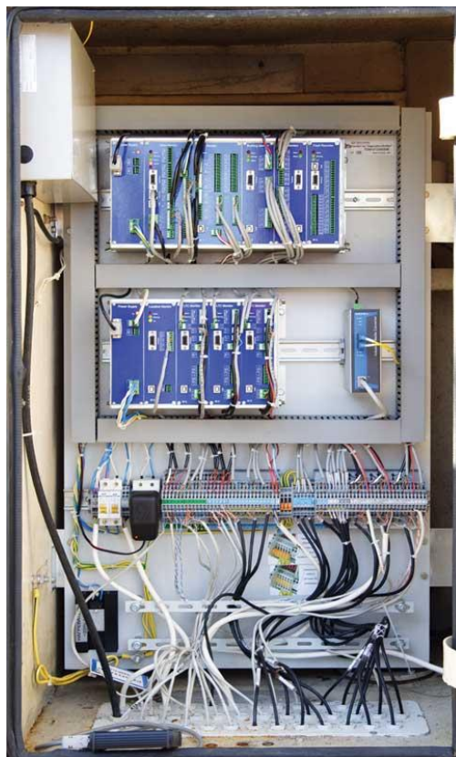
Рисунок 3.16 – Шкаф системы мониторинга марки TDM производства DIMRUS
